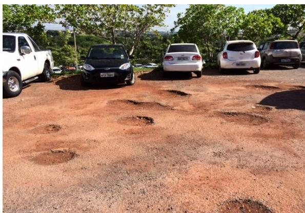
FIGURA 38 - SITUAÇÃO DO ASFALTO DO ESTACIONAMENTO DO PALÁCIO PAIAGUÁS E DA ASSEMBLEIA LEGISLATIVA ANTES DA MANUTENÇÃO
